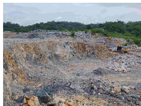
รูปที่ 2-23: การทำความสะอาดหน้างาน ก่อนการระเบิด
